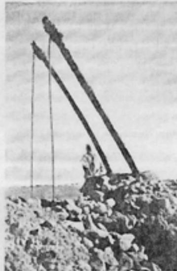
Pl. 37. — Puits à balancier double à Ksar el Hadj. Au second plan, les cônes d'évent d'une foggara.
