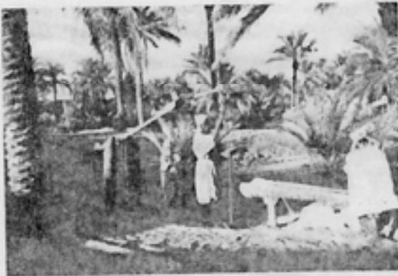
Pl. 61. — Puits à balancier avec le *frout* à In Hammou.
